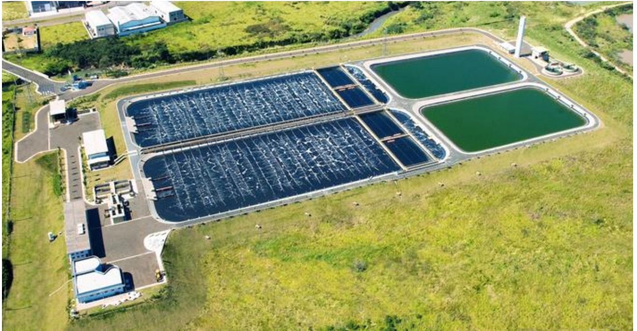
Figura 5.3 – Vista Geral da ETE Mário Araldo Candello.
