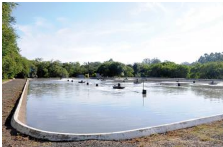
Figura 5.2 – Vista Geral da ETE São Lourenço
