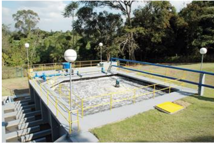
Figura 5.1 – Vista Geral da ETE Itaiçi
