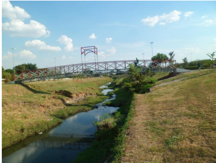
Figura 5.25 – Ponto de erosão no Córrego do Barnabé – Rua João Walsh Costa e Rua Antônio Angelino Rossi
