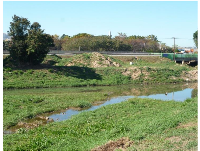
Figura 5.35 – Trecho Assoreado do Córrego do Barnabé – Próximo à Travessai T10
