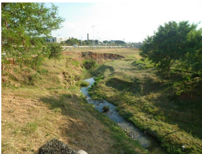
Figura 5.26 – Ponto de erosão no Córrego do Barnabé – Rua Custódio C. Carneiro e Rua Martinho Lutero
