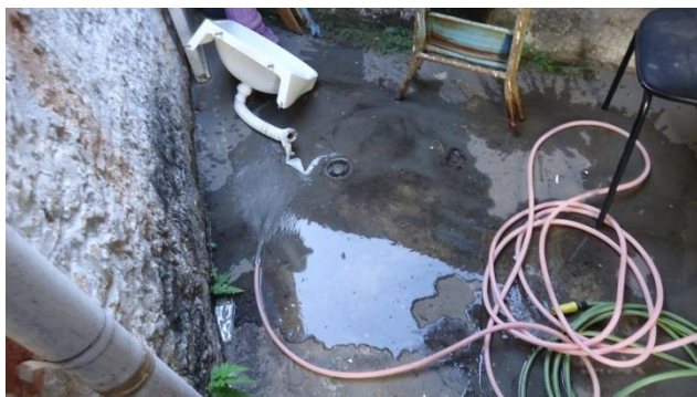
Figura 5.37 – Preparação do Local para Aplicação do Corante
