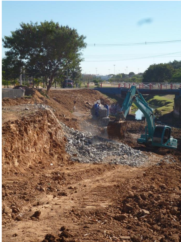
Figura 5.33 – Obras de Contenção de Encostas – Córrego do Barnabé
