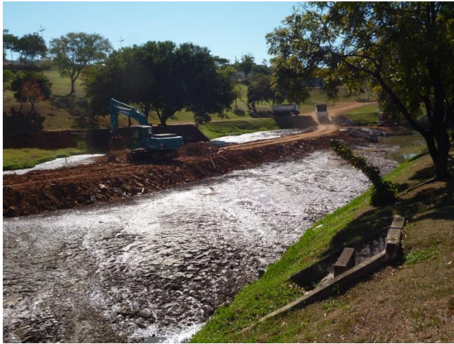
Figura 5.34 – Trecho Assoreado do Córrego do Barnabé – Obras de Desassoreamento
