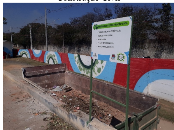
Figura 6.74. Vista do Ecoponto – Resíduos Construção Civil
