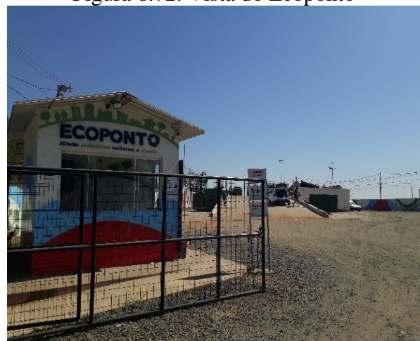
Figura 6.72. Vista do Ecoponto
