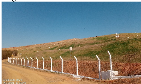
Figura 6.118. Vista do Aterro Sanitário
