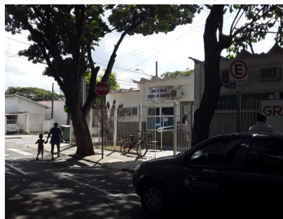
Figura 6.107. Vista de um pequeno gerador – UBS
