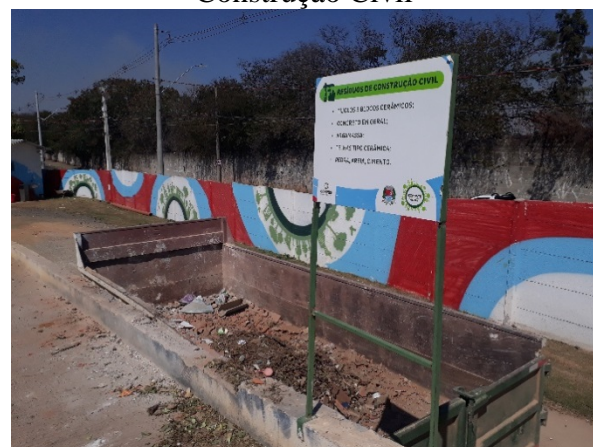
Figura 6.74. Vista do Ecoponto – Resíduos Construção Civil
