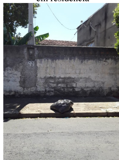
Figura 6.59. Vista do acondicionamento em residência
