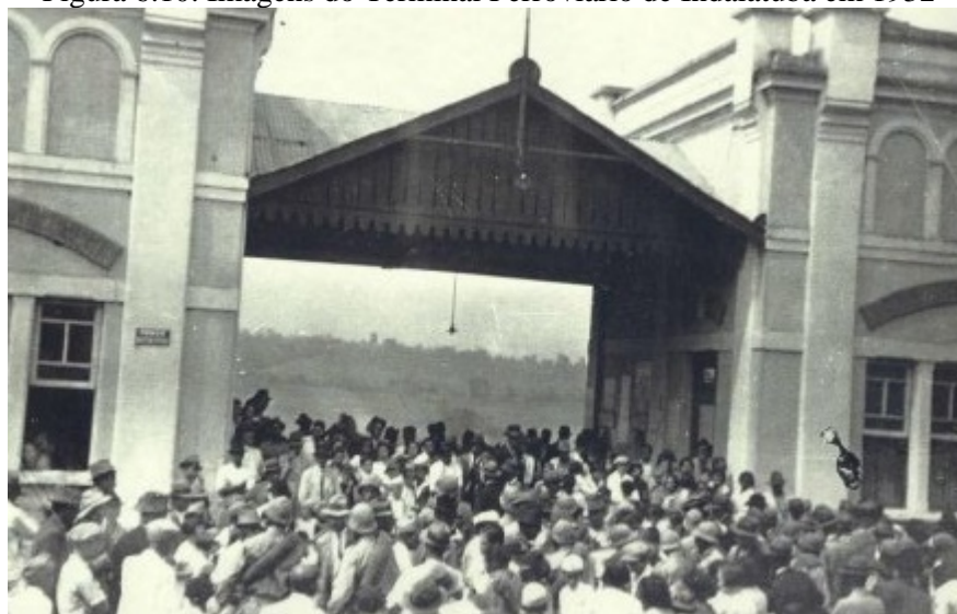
Figura 6.10. Imagens do Terminal Ferroviário de Indaiatuba em 1932
