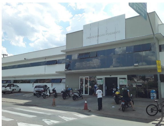
Figura 6.106. Vista de um grande gerador – Unidade de Pronto Atendimento
