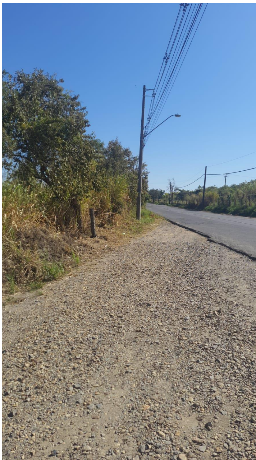
Visão do trafego de veículos
