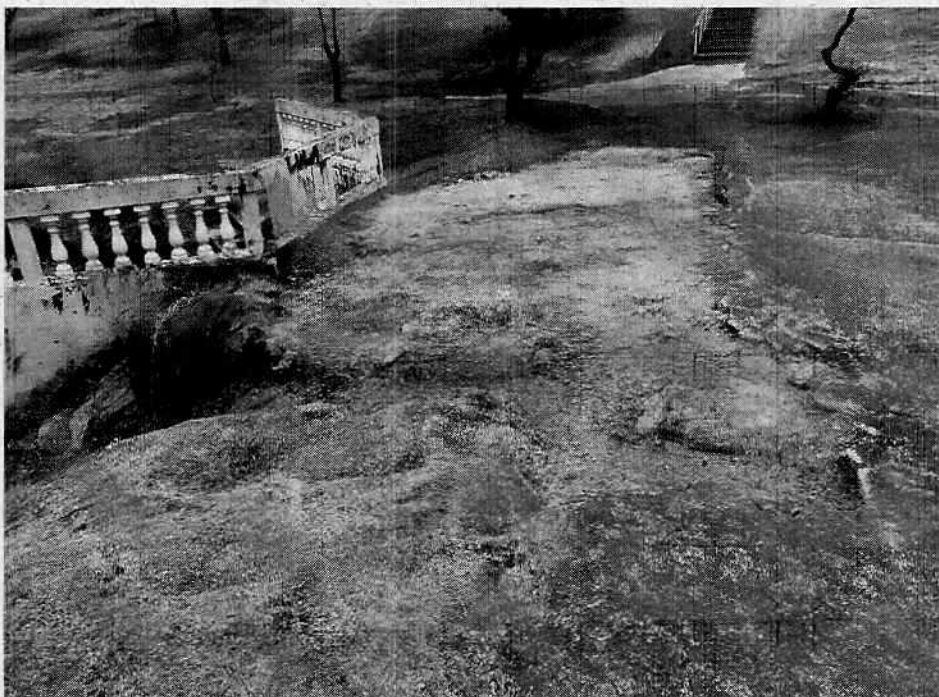
Imagem 18 - Irregularidades na estrutura do calçamento.
